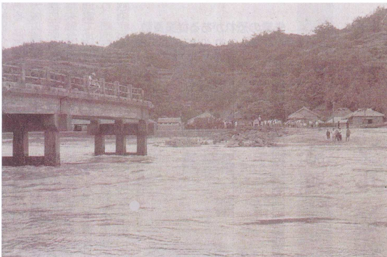
コンクリート製の大浦橋が津波で流される。
